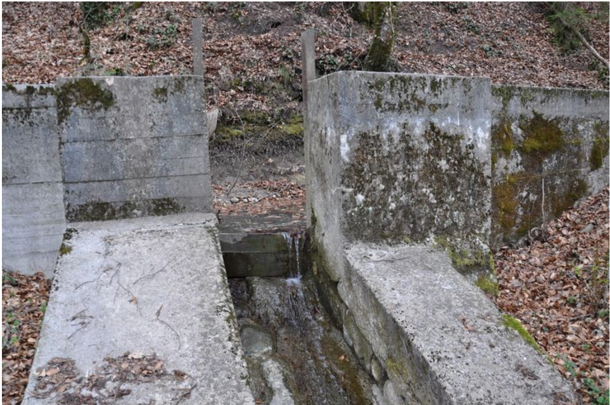
Détail du trop plein
