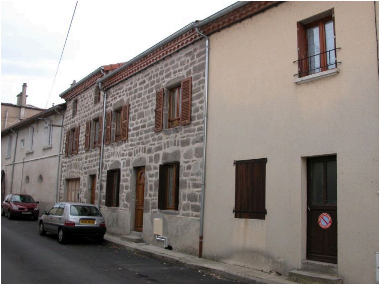
1986 AE 357. 3 rue des Carrières. Ferme avec cuvage, vue d'ensemble des façades sur rue.
