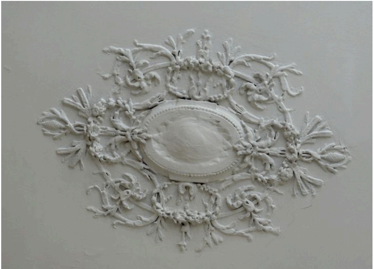
Appartement du 1er étage, pièce, actuel bureau du directeur de l'Institut de Chimie Industrielle, décor du plafond
