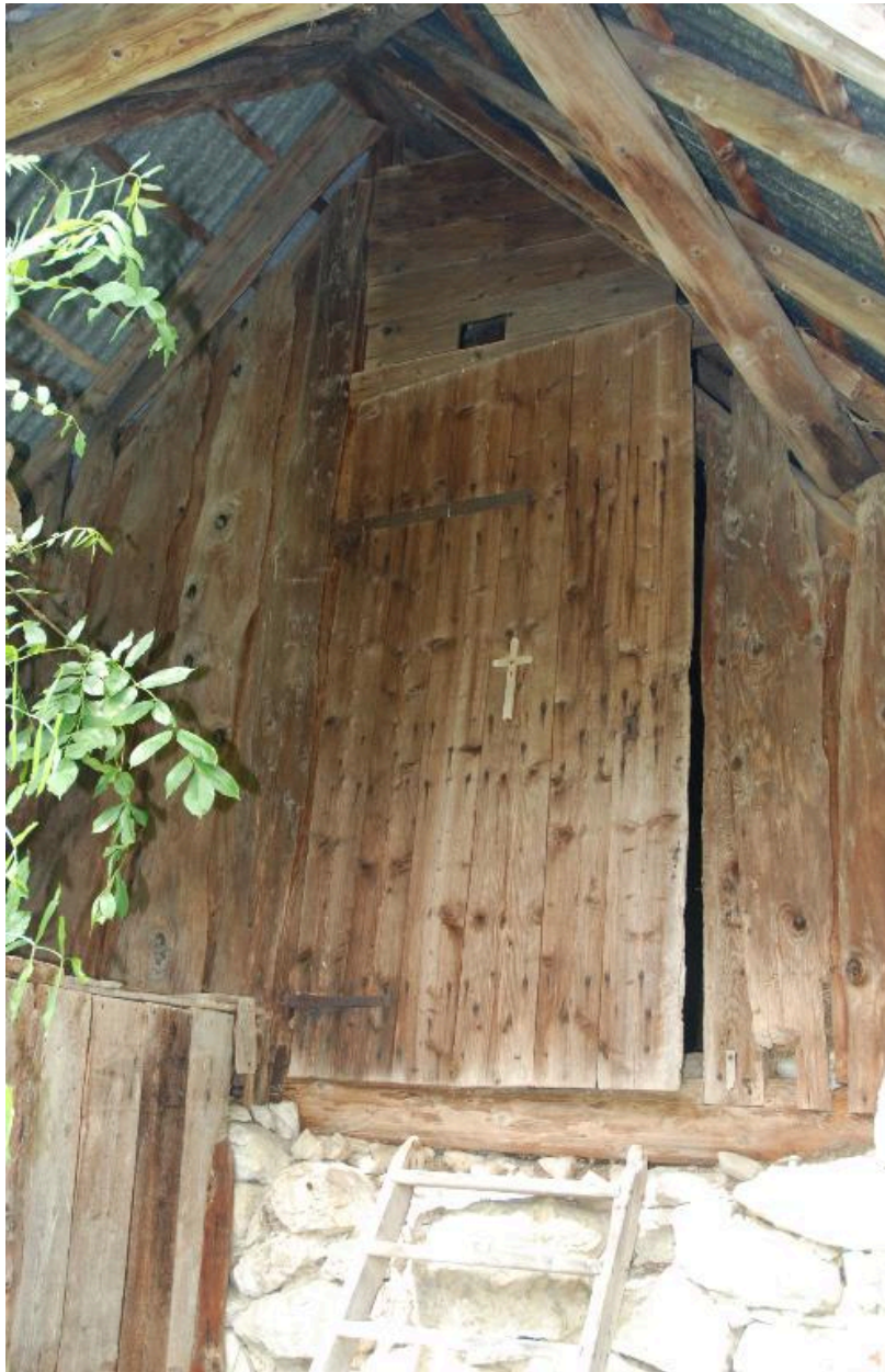
Détail de la porte haute du fenil.
