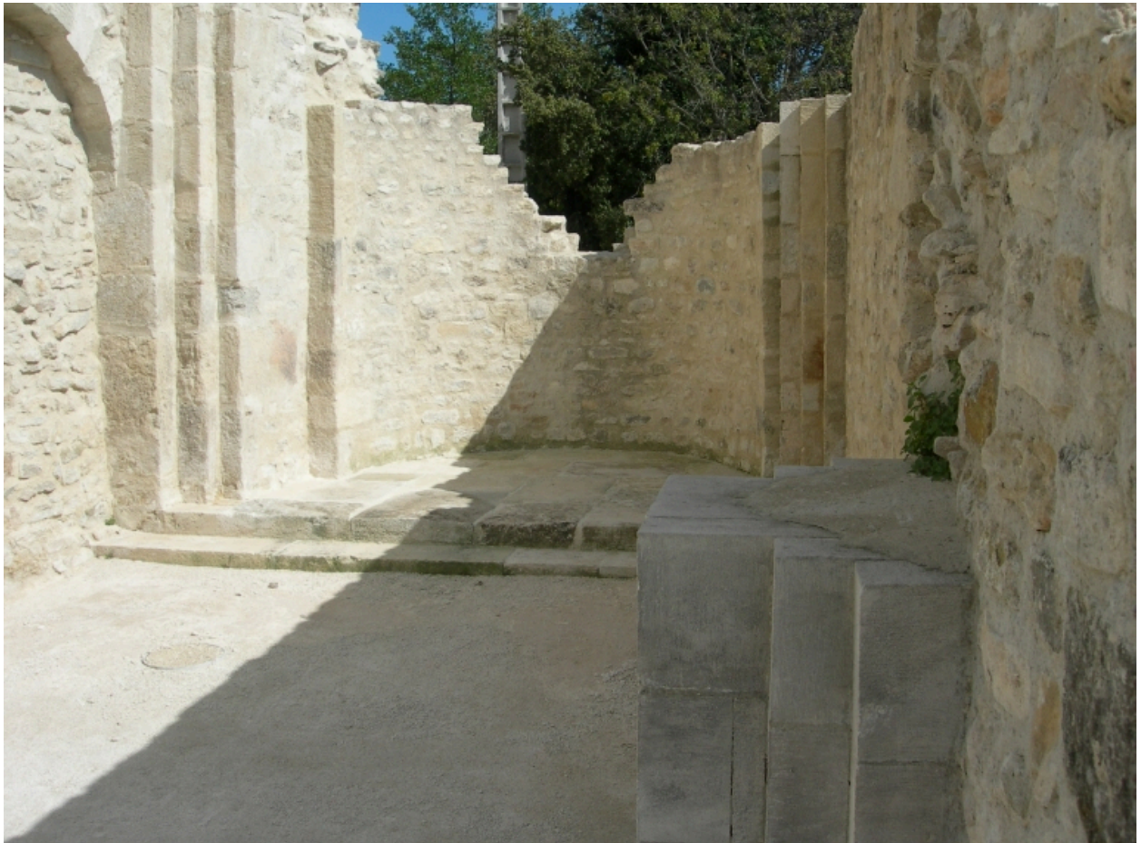
Chapelle restaurée, vestiges de la chapelle Saint-Anne (sud).
