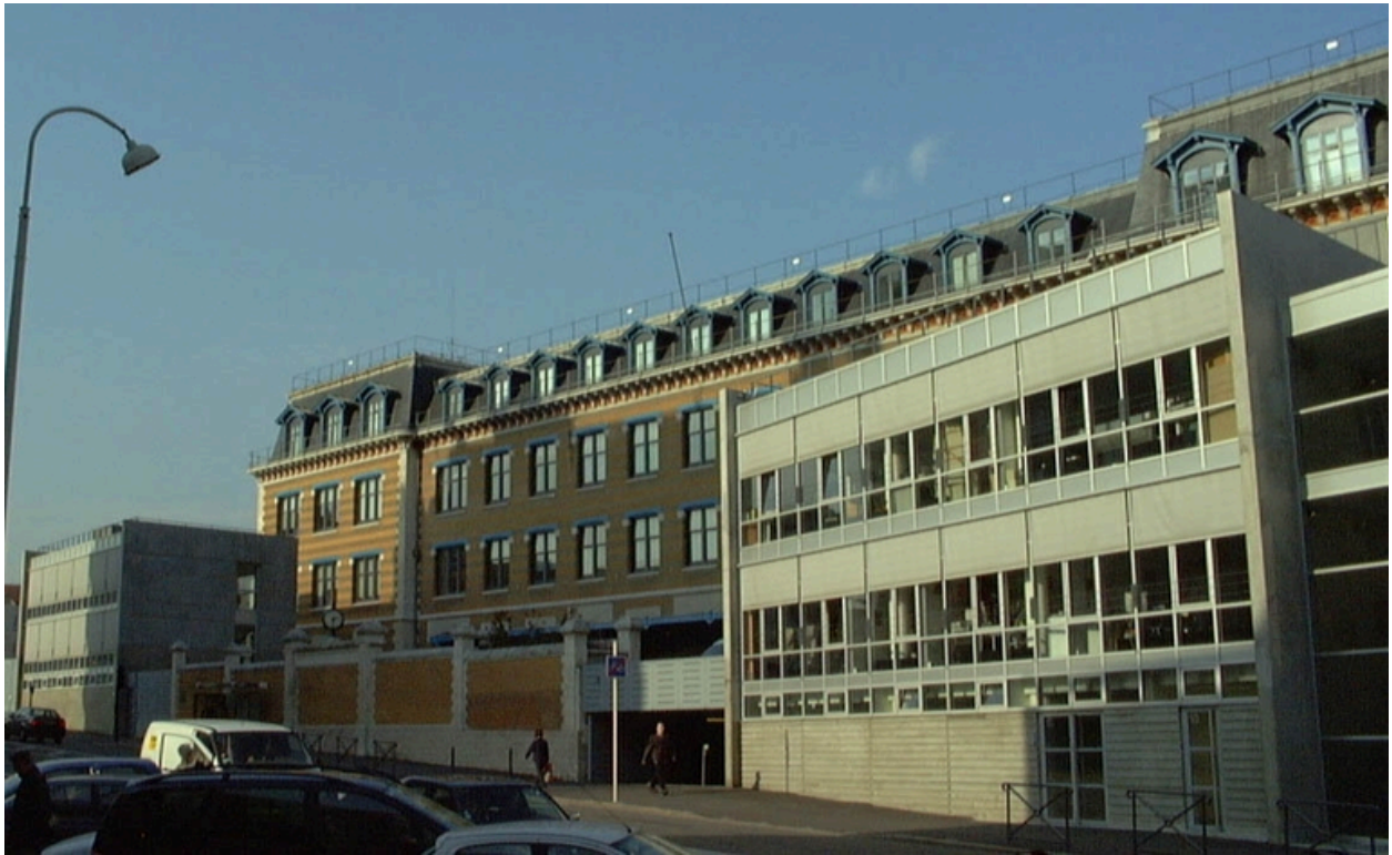
Façade sud réhabilitée
