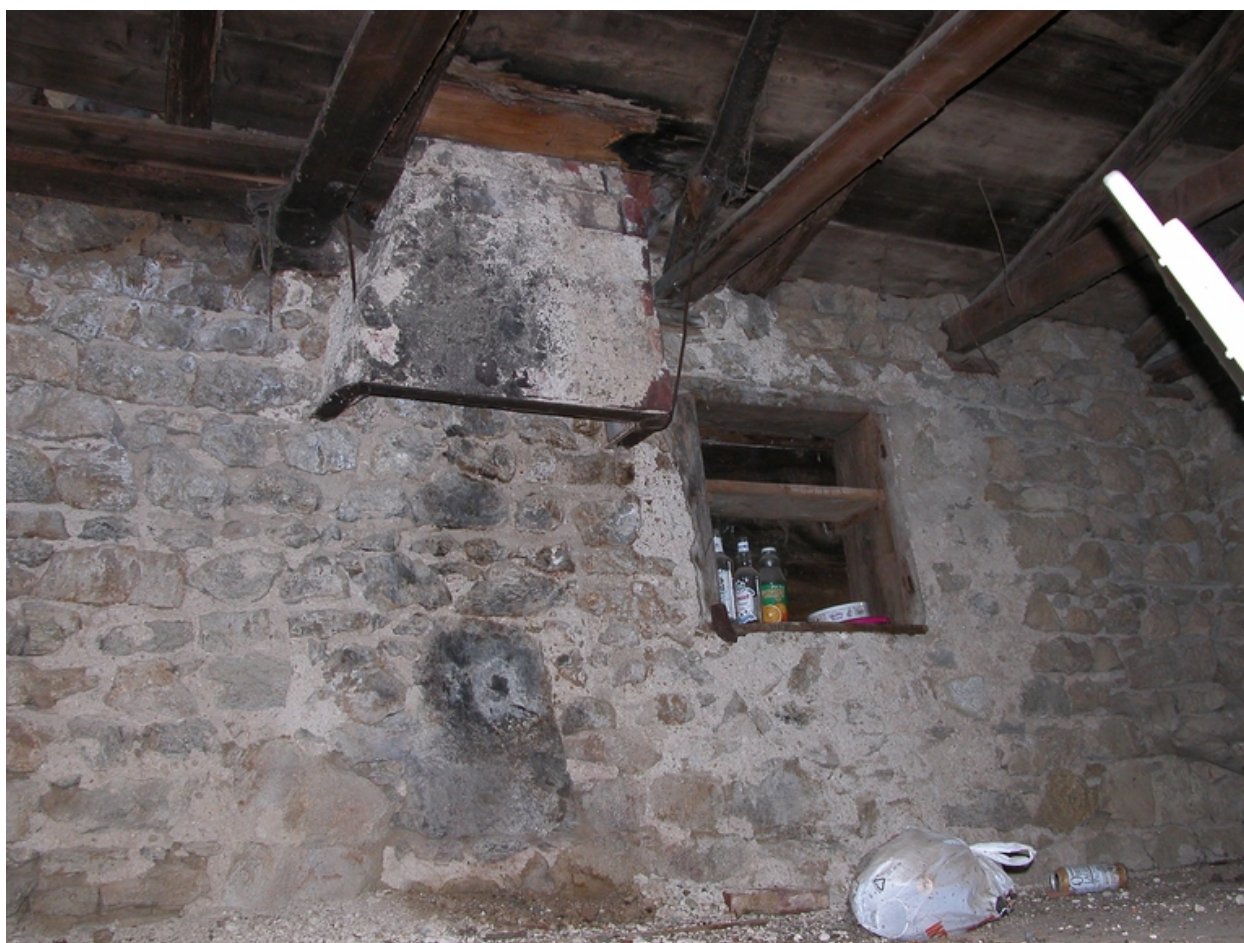
Vue de l'étage : cheminée, placard.
