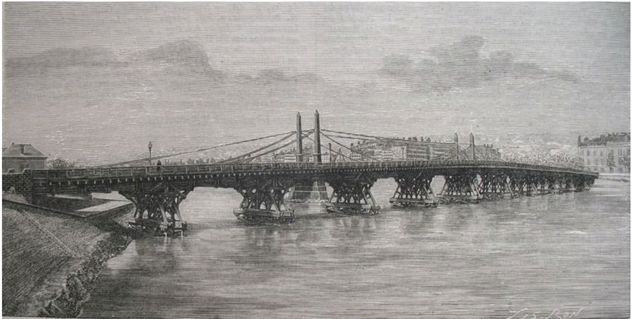
Fig. 2. La passerelle provisoire du pont du Midi, à Lyon (d'après une photographie de M. Garcin, à Lyon) (extr. de : NANSOUTY, Max de. In Le Génie civil, t. XIII, n° 23, 6 octobre 1888, fig. 2, p. 354)
