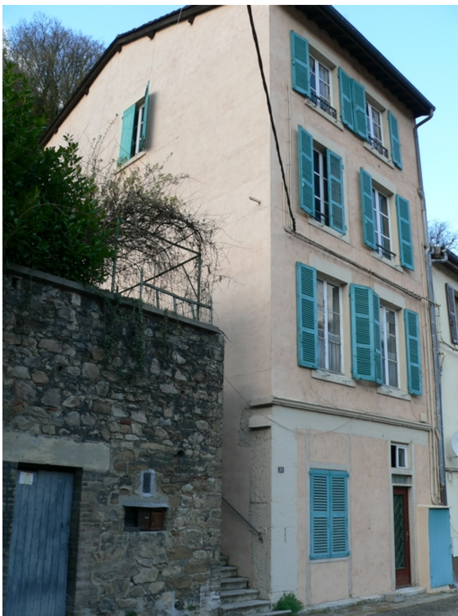
Façade sur rue et latérale gauche
