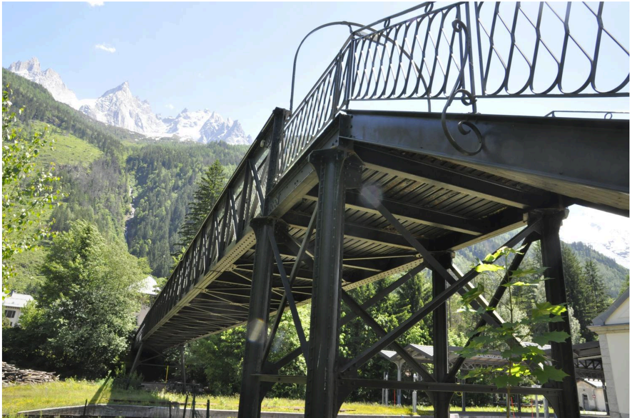
Passerelle métallique du côté de la gare ferroviaire de Chamonix
