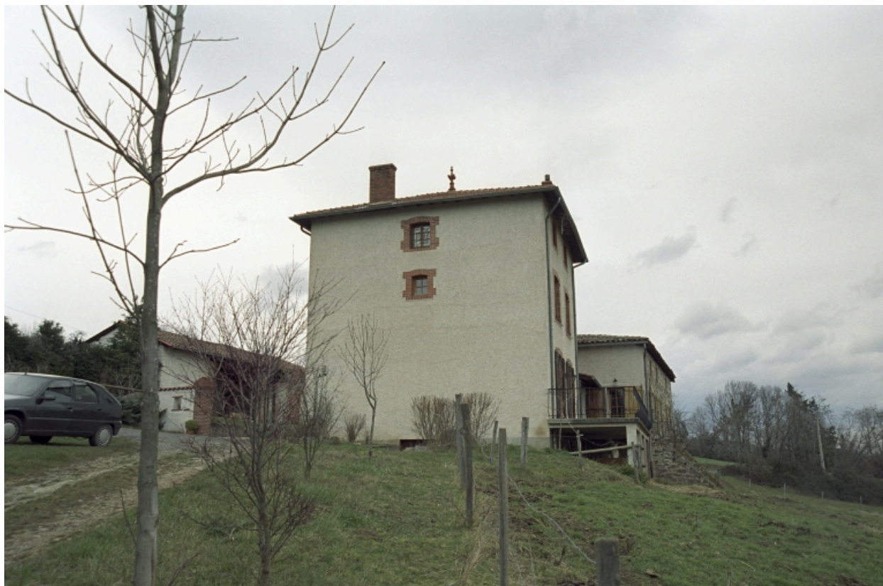
Trelins, les Sagnes (1986 B2 1420, 1421), type C1. Vue latérale droite : élévation postérieures du logis et de l'ancien cuvage.
