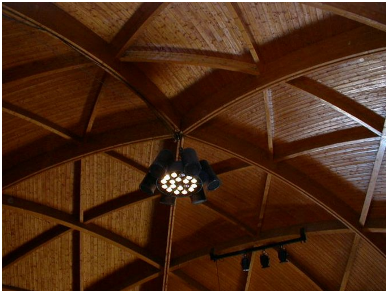
Détail de la charpente
