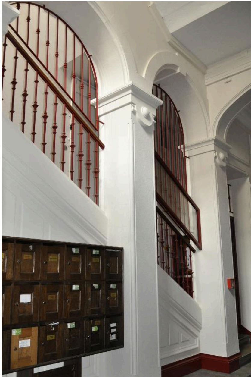
Vue du départ de l'escalier (première volée décalée à droite du passage cocher)
