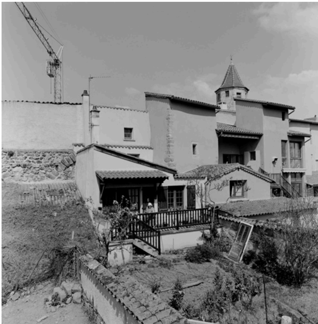
Vue du fossé (parcelle 1999 AD 143 et 166, face aux parcelles AD 238, 166) et des vestiges de l'enceinte, depuis le sud-ouest.
