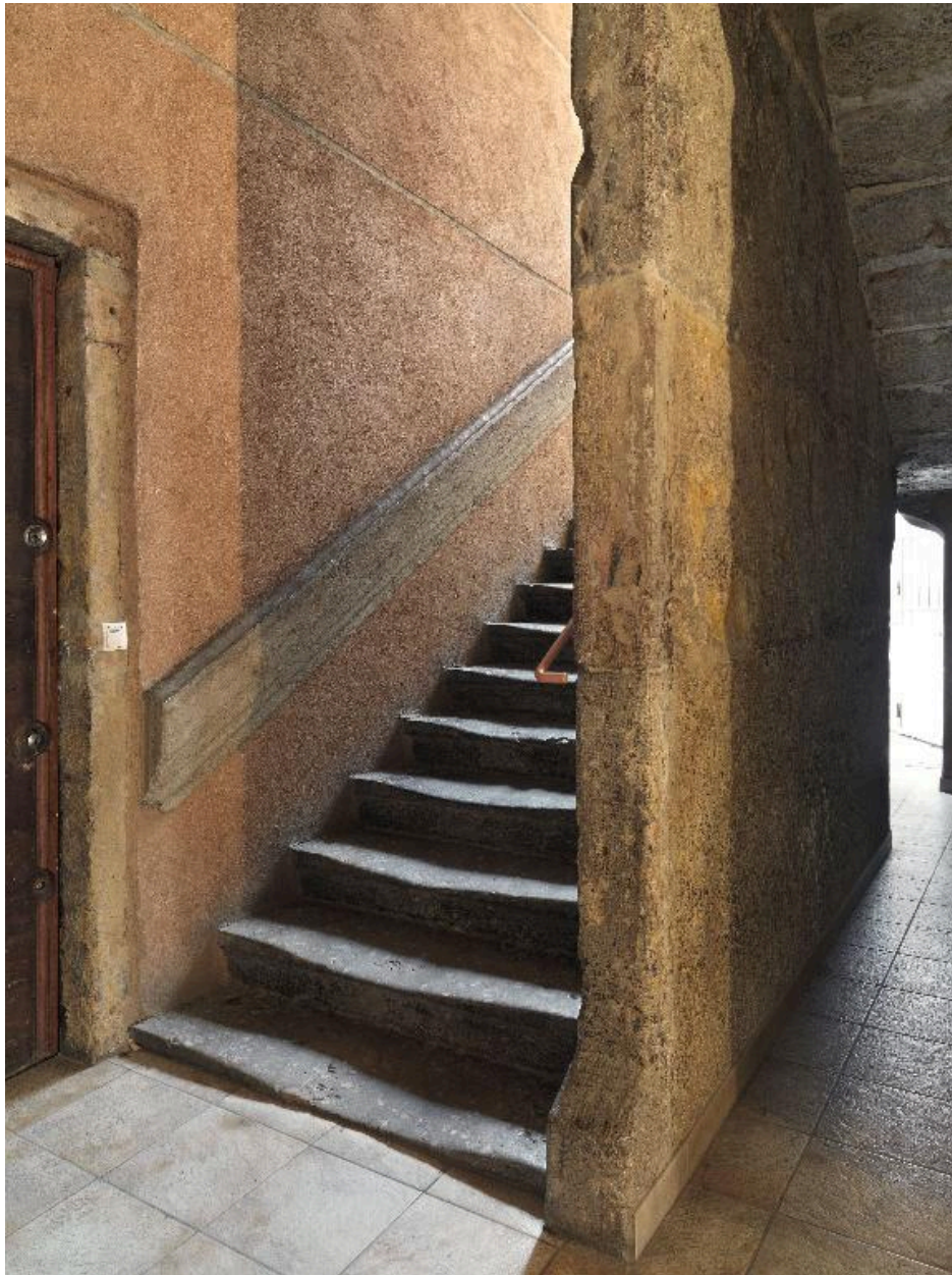
Départ de l'escalier du n°14 rue Dumenge commun avec le n°12
