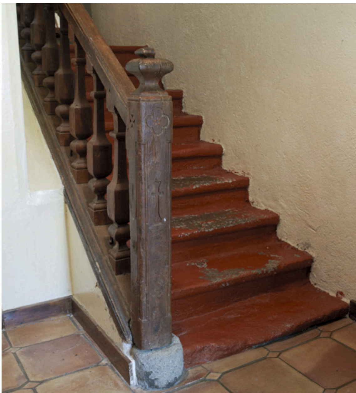
Vue de l'escalier.
