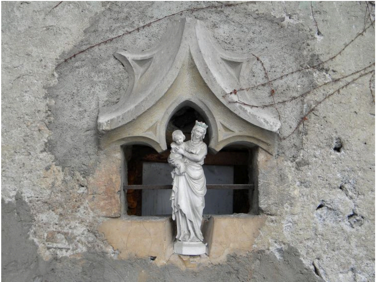
Détail de la baie trilobée provenant peut-être de l'ancienne chapelle.
