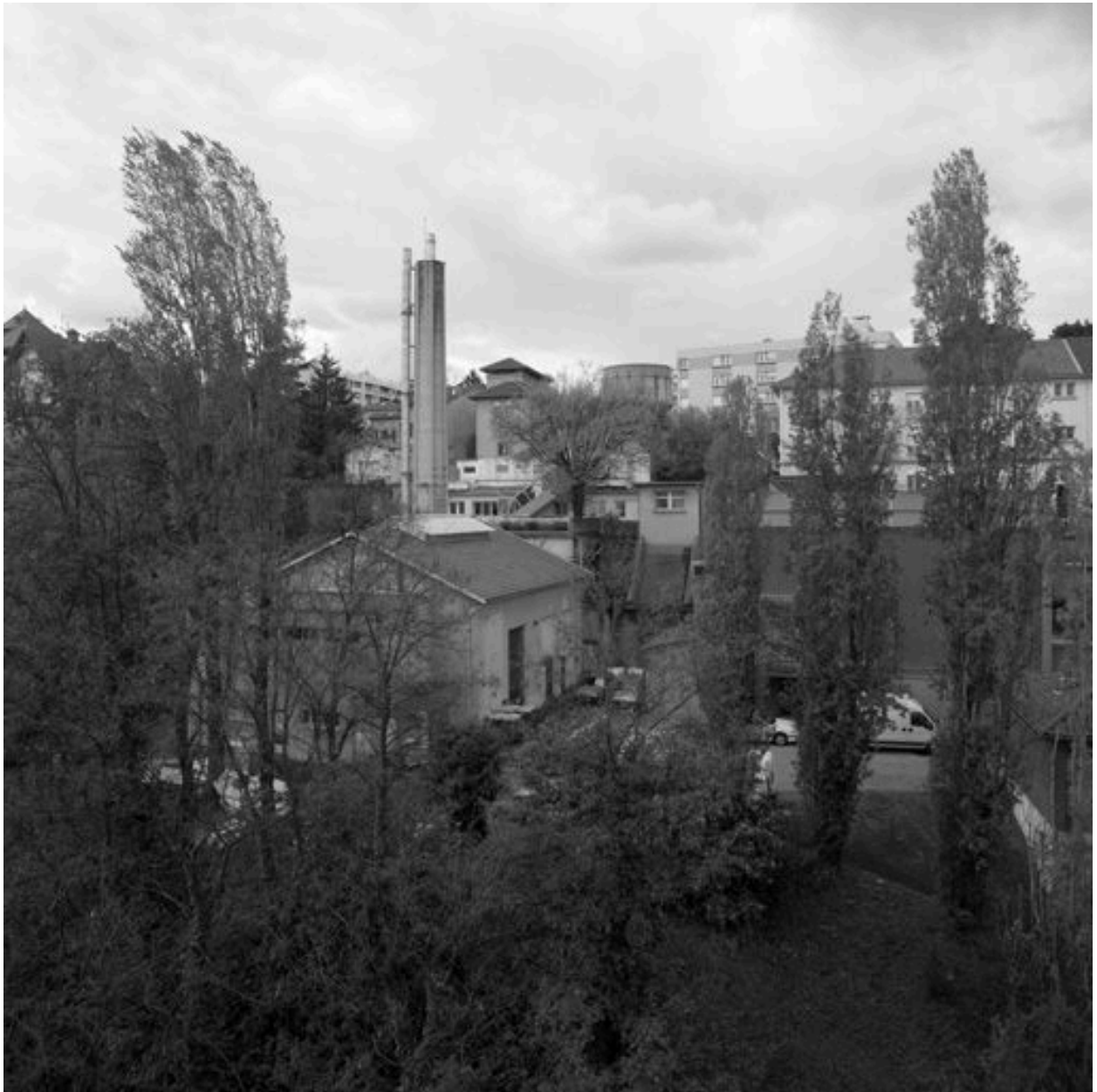
Bâtiment 1, vue générale
