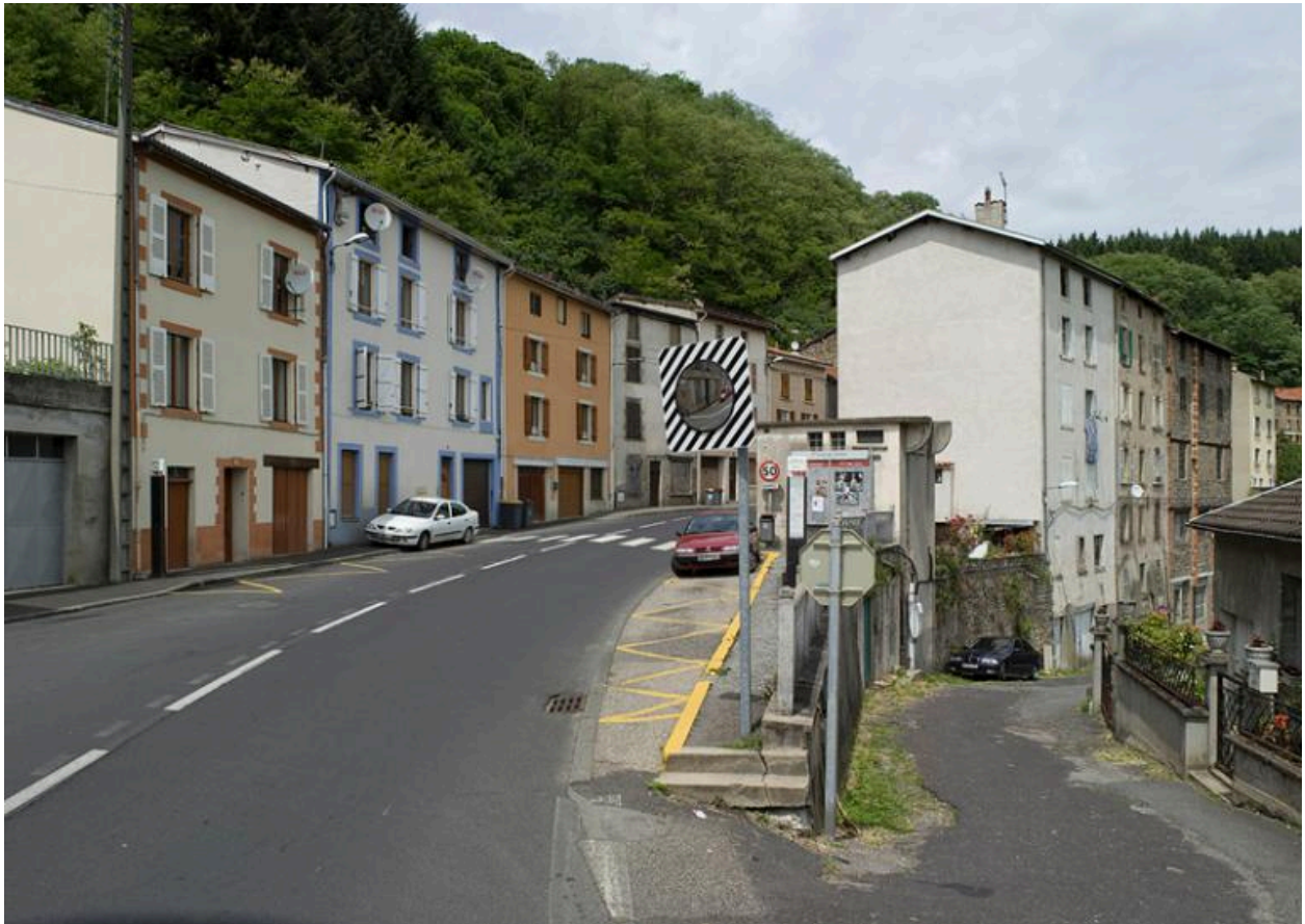
Carrefour de la route (début de la section de la rue Carnot) avec le chemin des Charles (descendant à droite).
