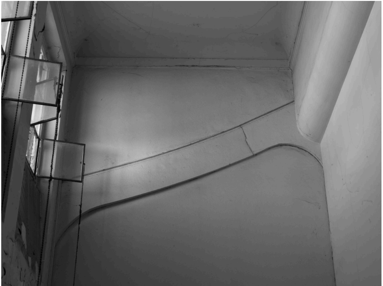
Bâtiment C. Fenêtres du vestibule d'accès au dôme Pascalon
