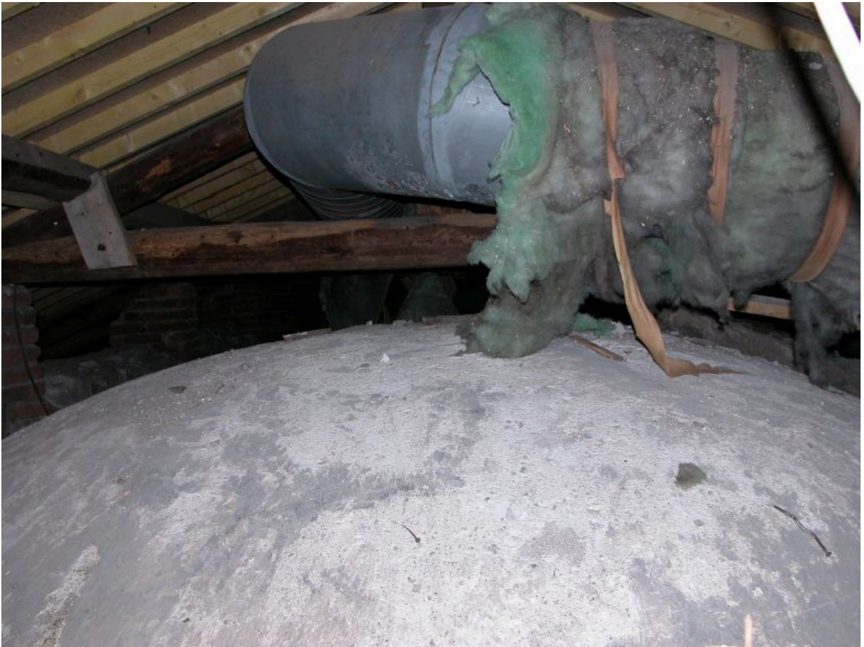
Vue d'ensemble du dessus des voûtes de la nef.
