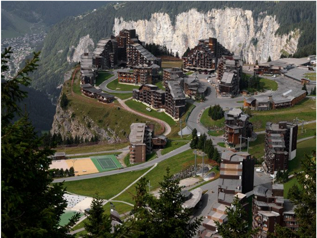
Vue depuis le sud-est
