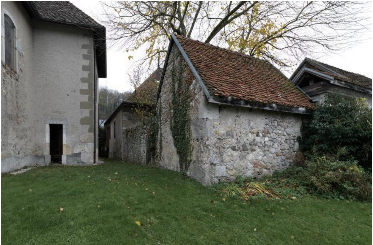
Vue de l'élévation coté ouest : porte et angle du transept.
