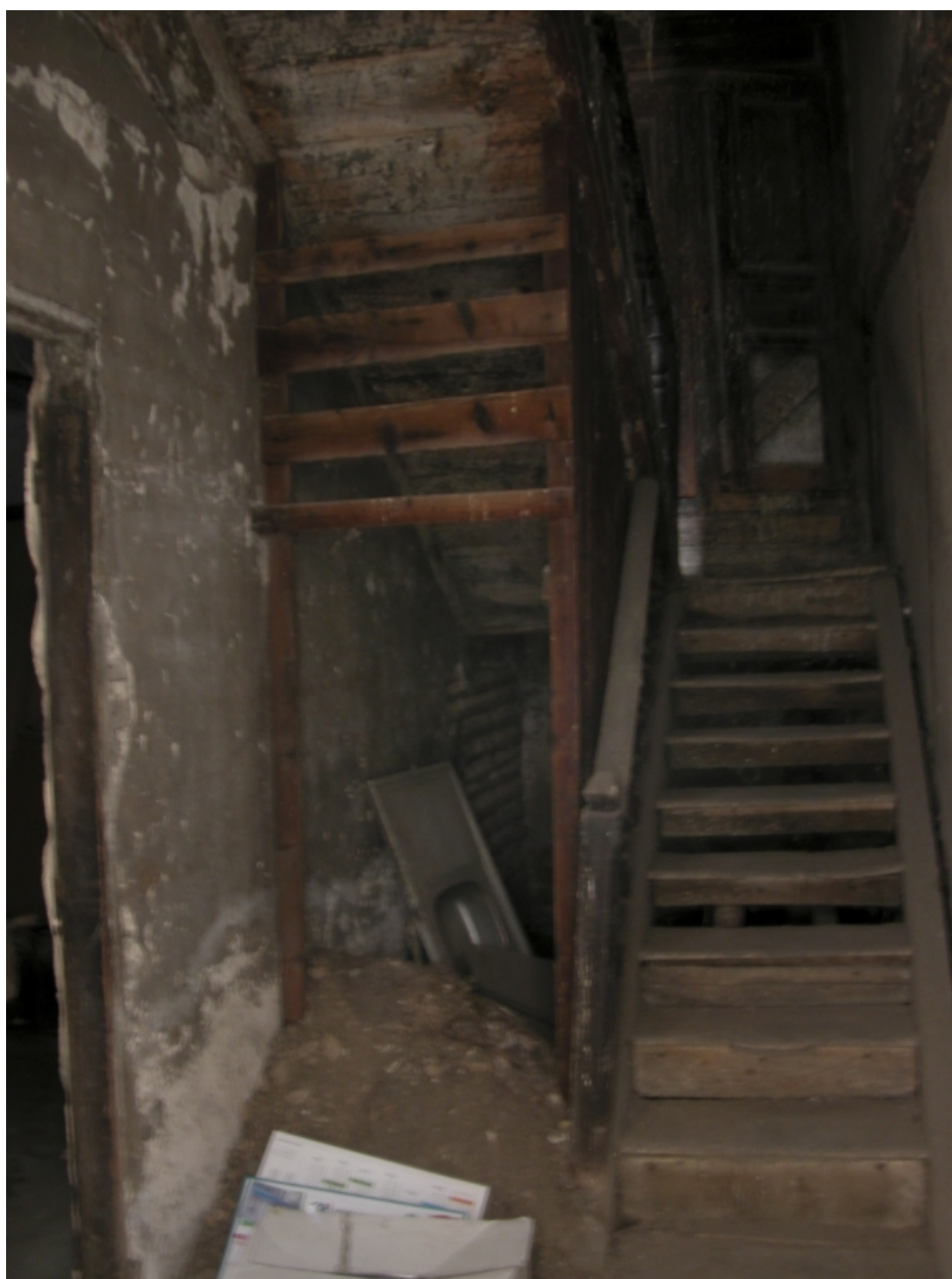
Îlot 2. Roanne (rue de) 11. Vue générale de la montée d'escalier en bois (parcelle 546)
