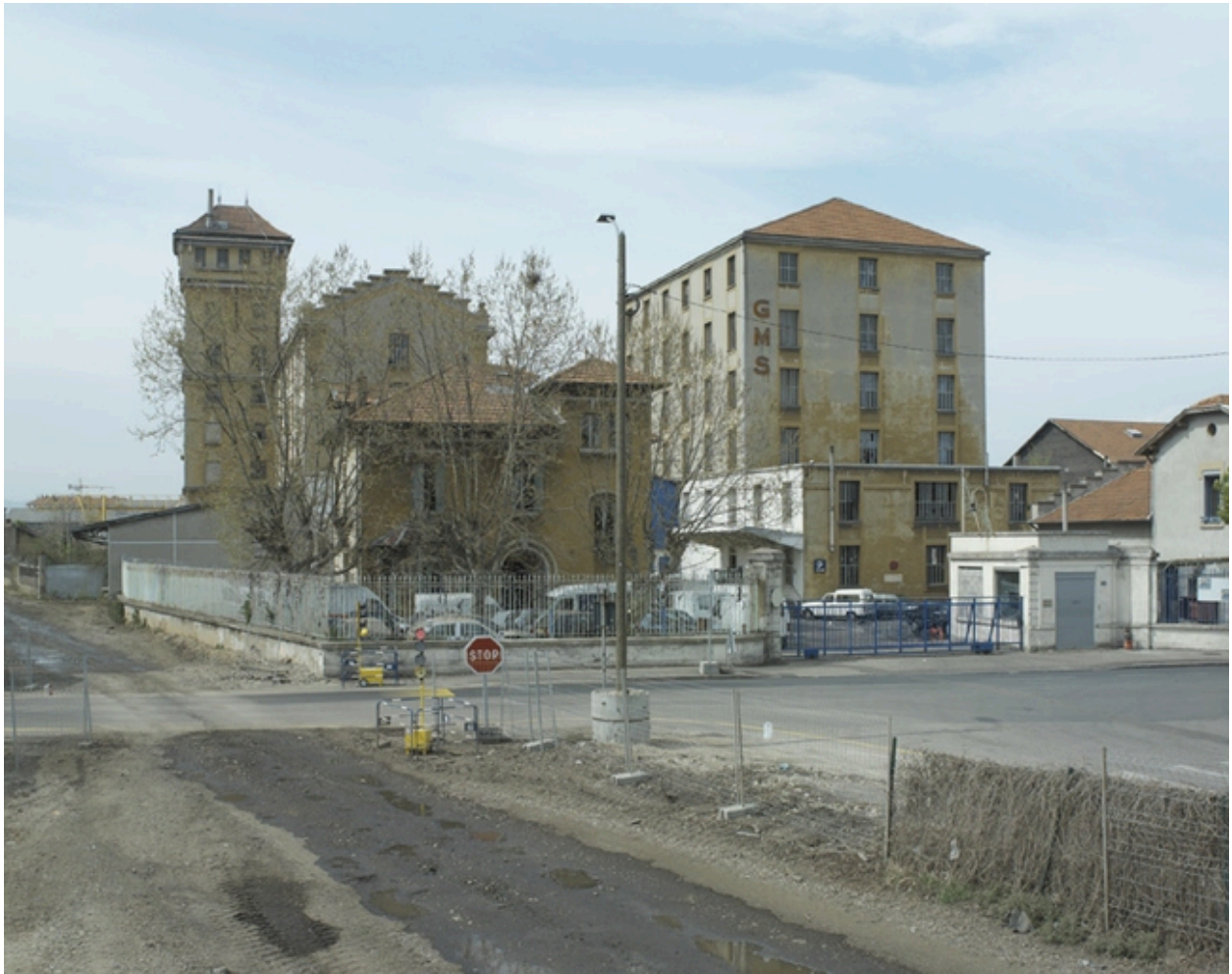
Vue générale ouest des Grands Moulins de Strasbourg
