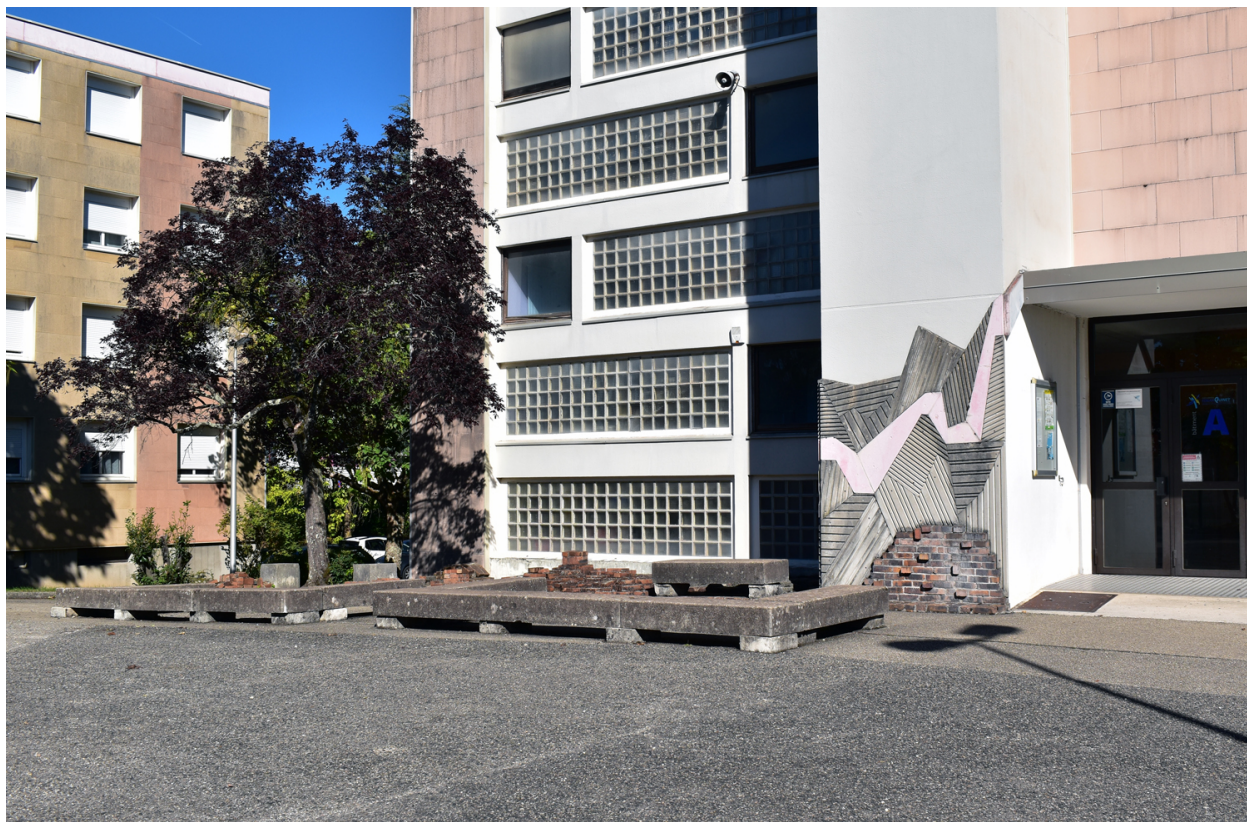
Bâtiment A, " mur pignon " : vue d'ensemble du décor depuis le nord-ouest
