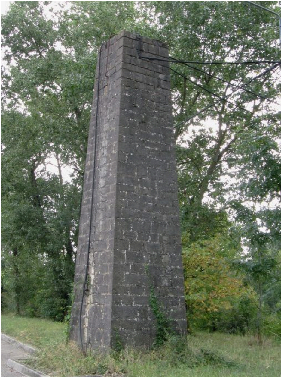
Pile droite, angle ouest, vue générale (depuis la rive droite)
