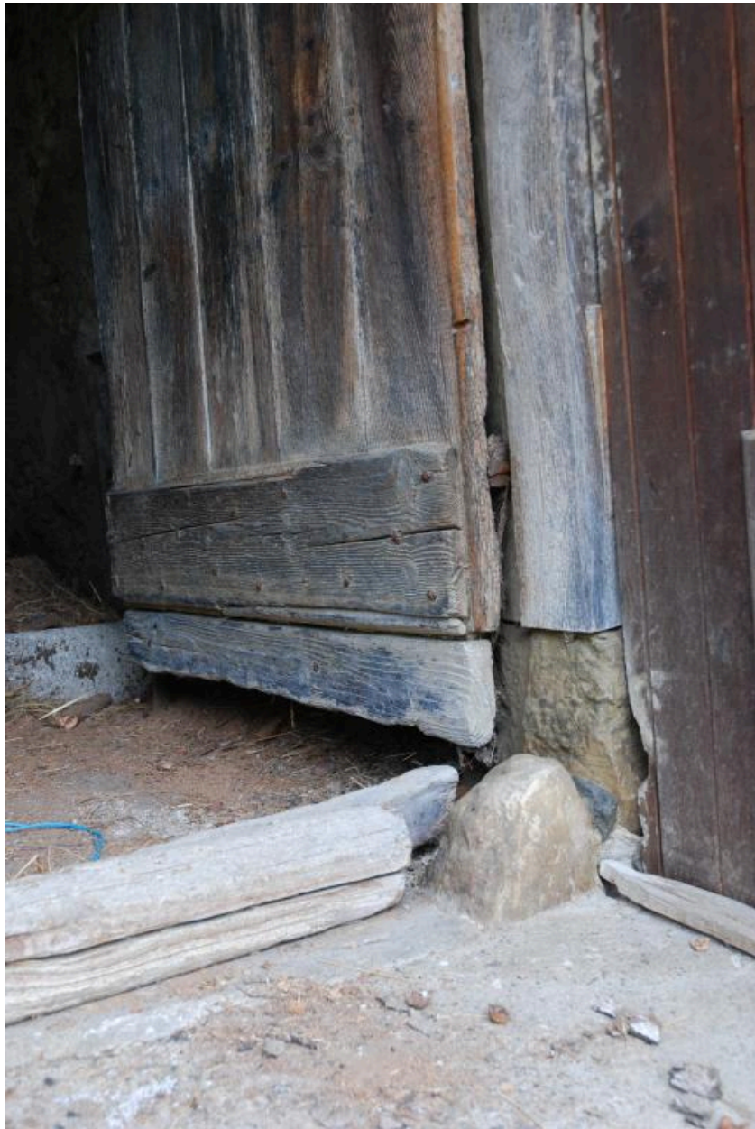
Détail de mise en oeuvre : porte de la grange.
