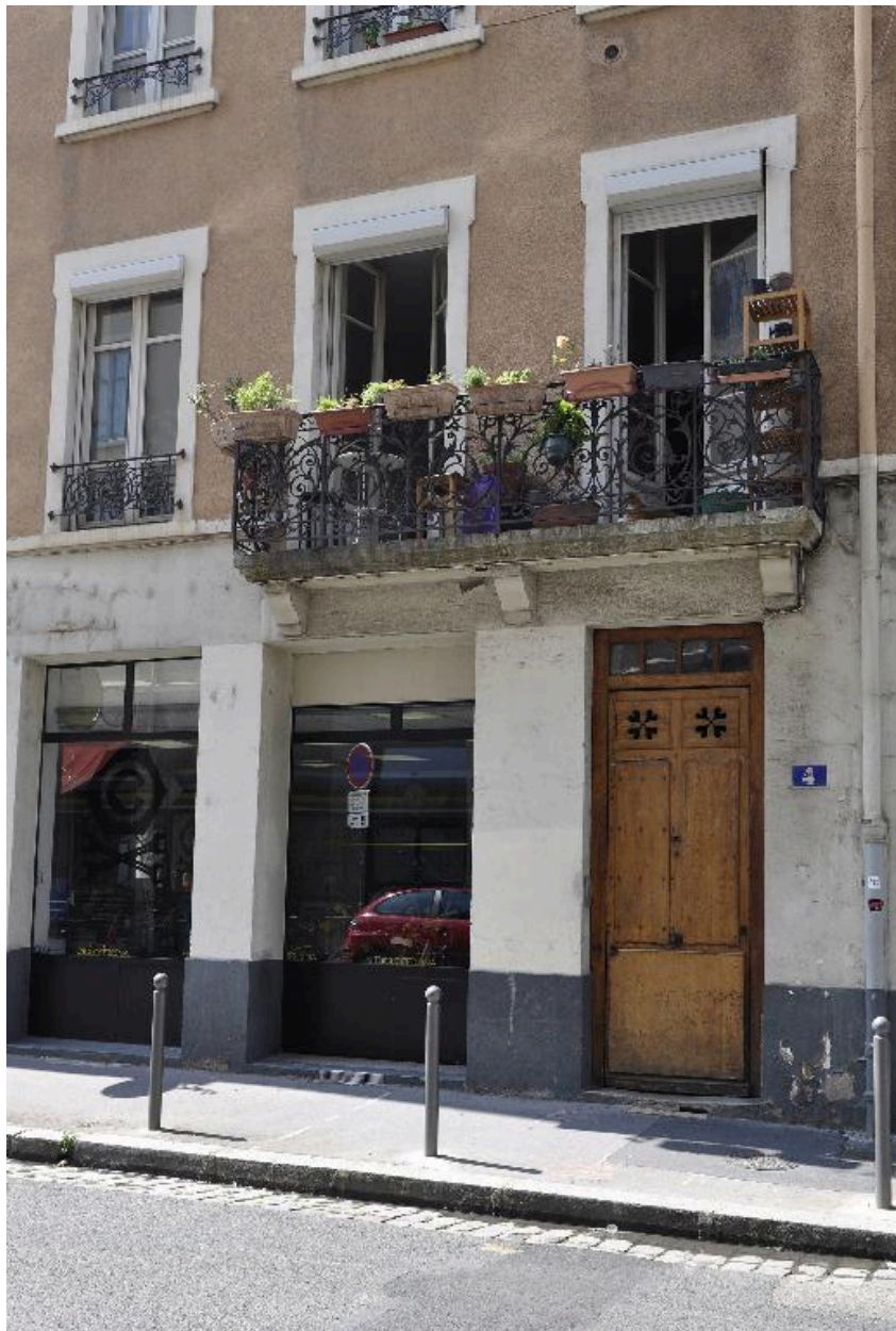
Vue actuelle du rez-de-chaussée, porte surmontée d'un balcon
