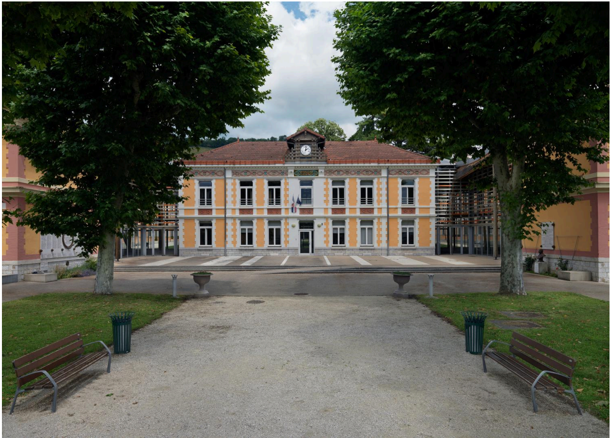
Bâtiment de l'administration
