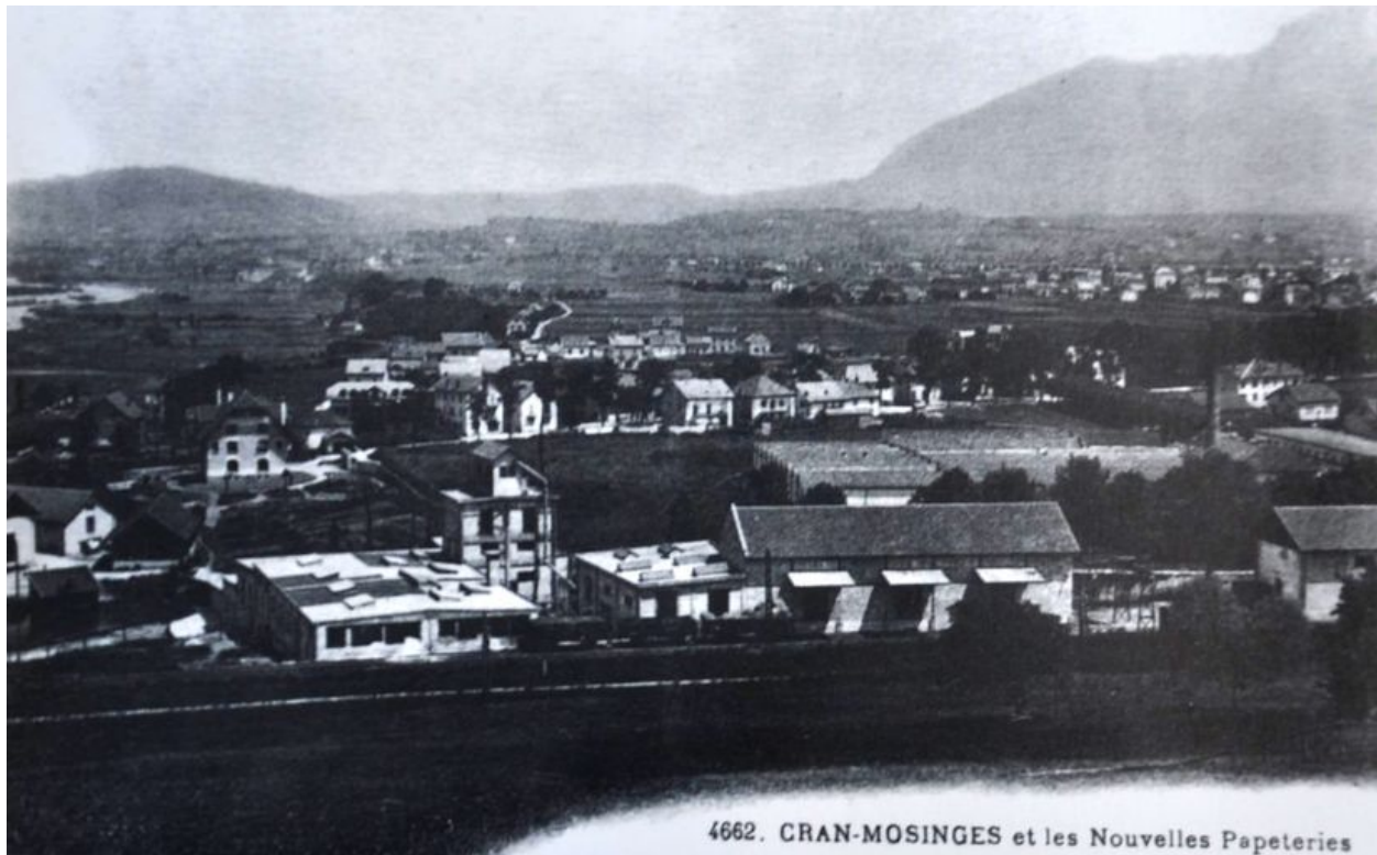
Vue de la gare ferroviaire de la Papeterie de Cran.1926.
