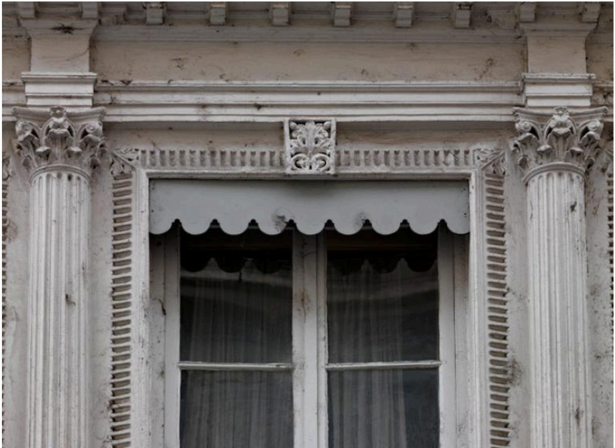
Élévation antérieure, premier étage carré : ornementation d'une baie
