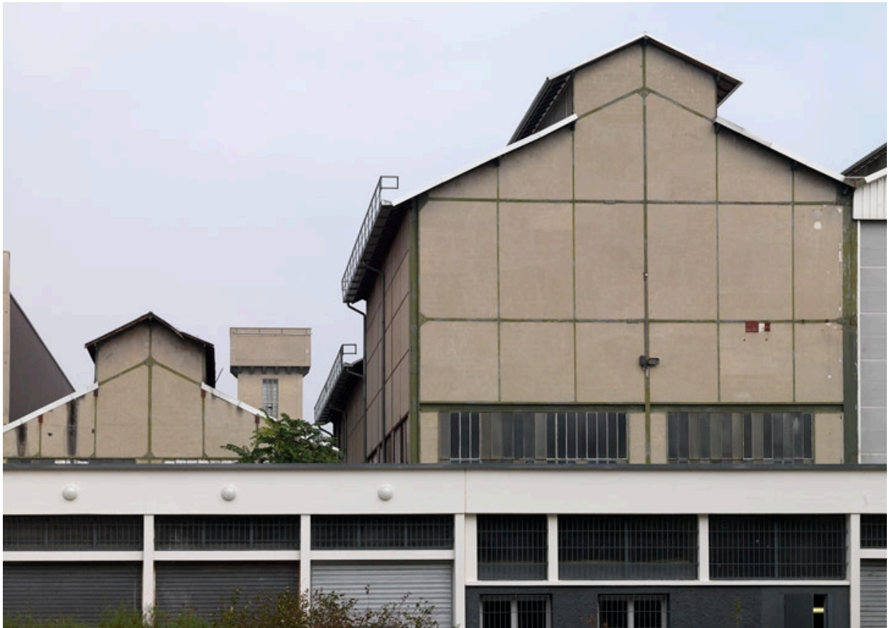
Détail ossature métallique
