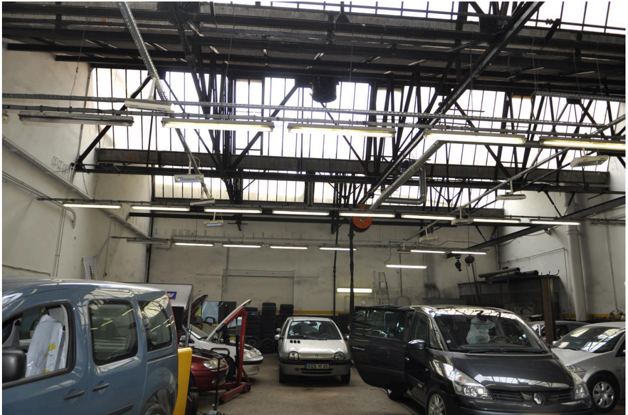
Vue intérieure, garage à charpente métallique
