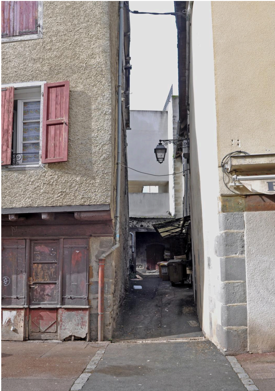
Ancien accès à la cour de la cuisine (visible sur le plan de 1791) depuis la rue du Monastère
