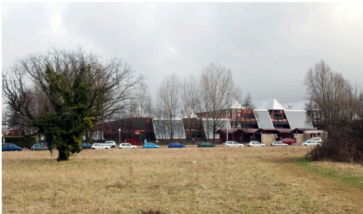
Bâtiment A. Vue partielle depuis le sud-ouest
