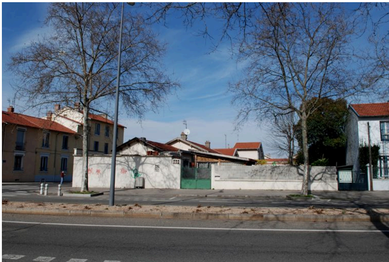
Elévation antérieure, mur de clôture
