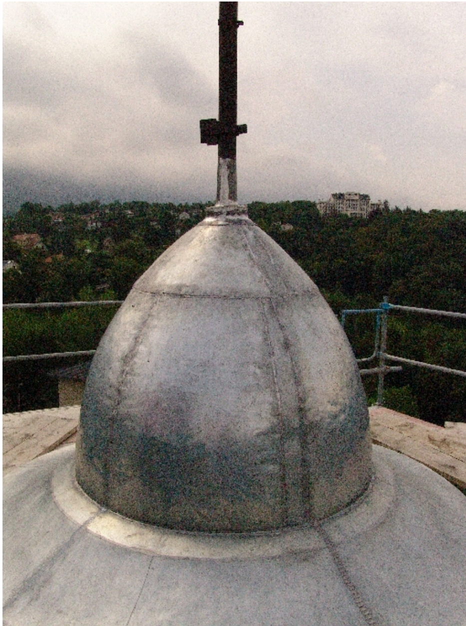
Couverture du lanternon
