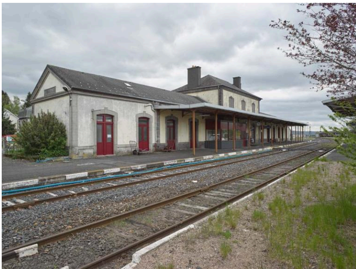
Gare de Laqueuille, côté voies.
