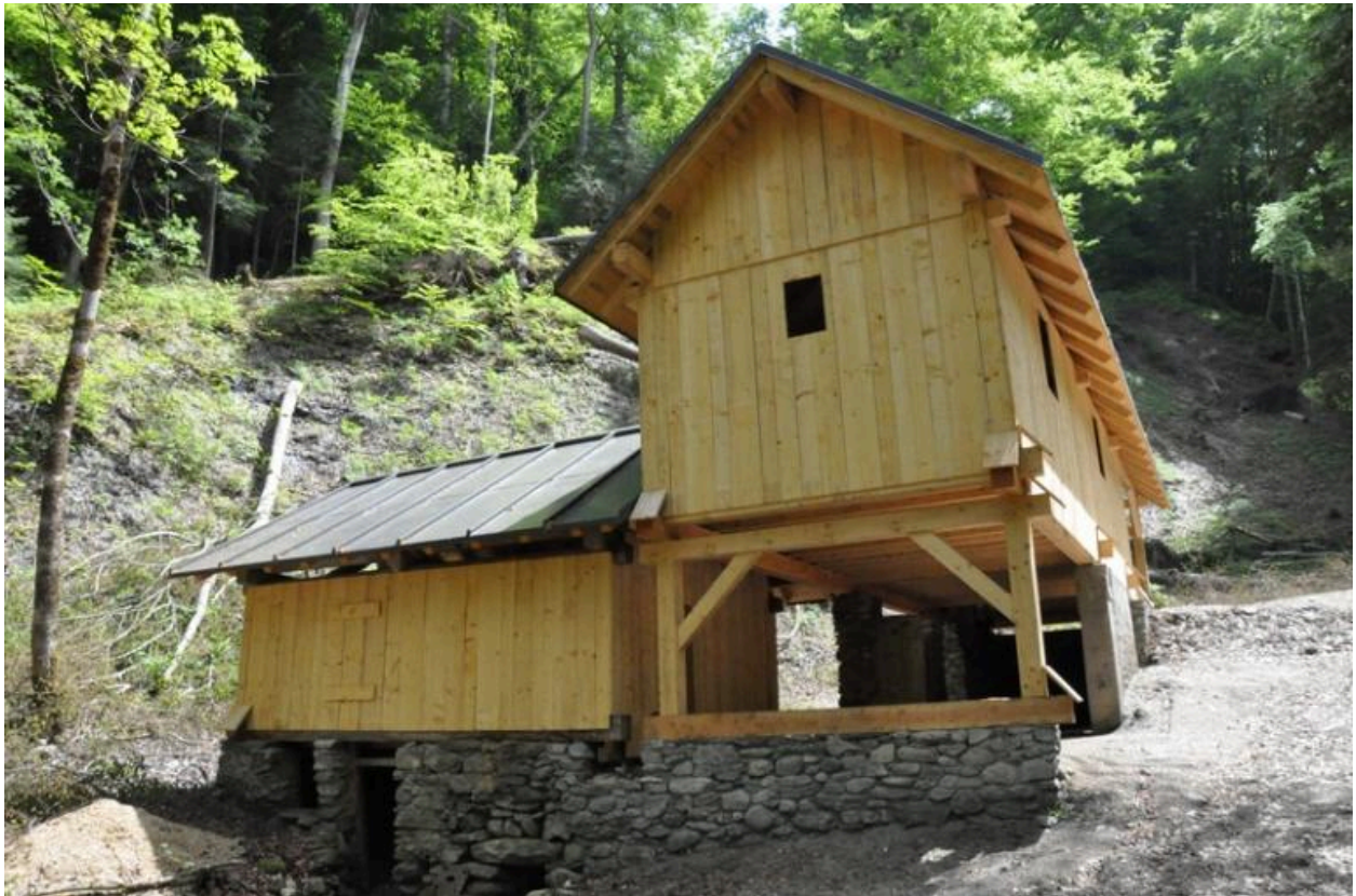
Pignon nord du bâtiment après restauration, 2015.
