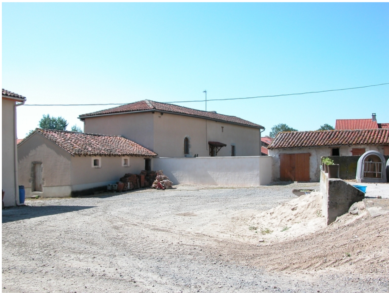
Vue du logis côté cour, depuis le nord-ouest.
