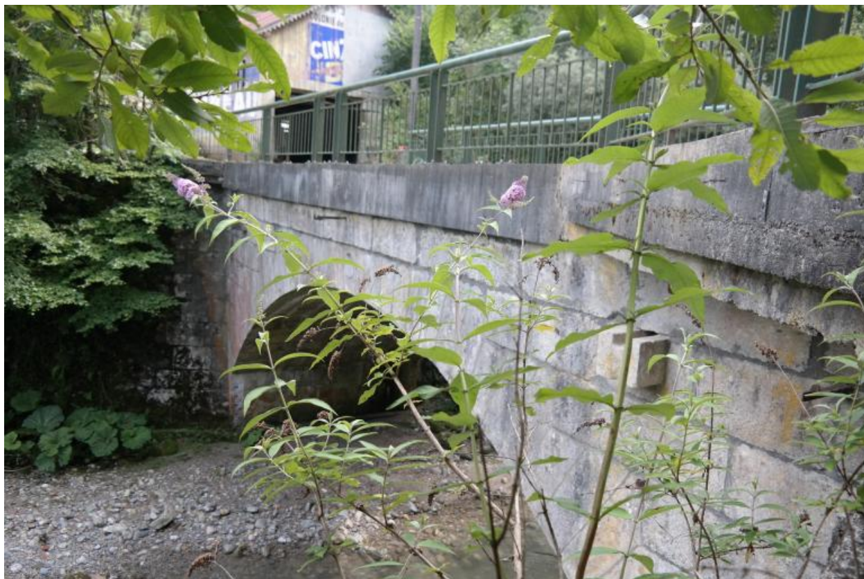
Pont de Bioge, vue de la face aval
