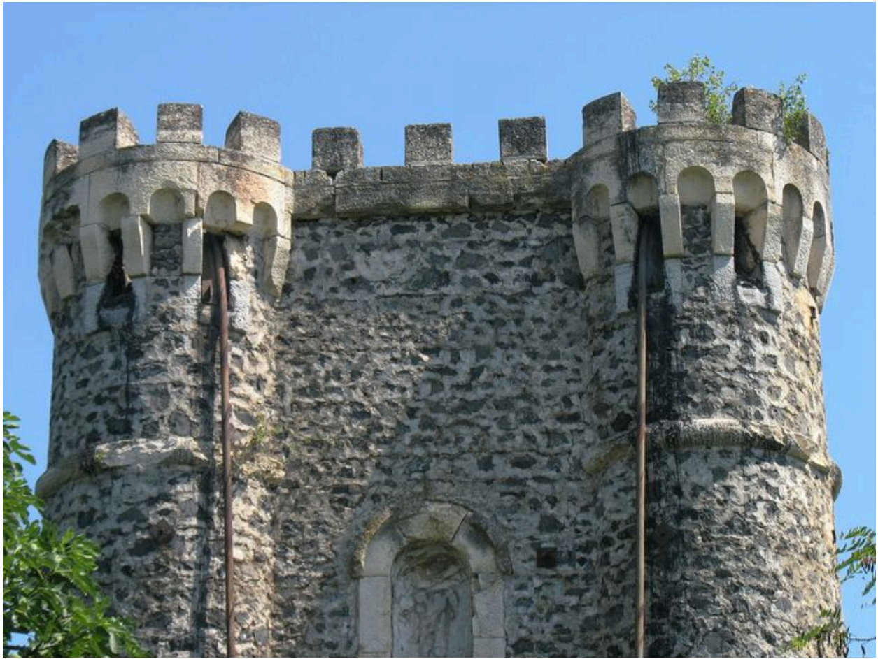
Tour formant tête de pont sur la rive droite, face nord-ouest : vue du crénelage sommital
