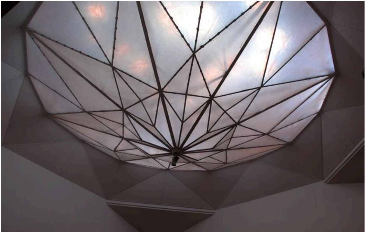
Vue des dalles du lanterneau
