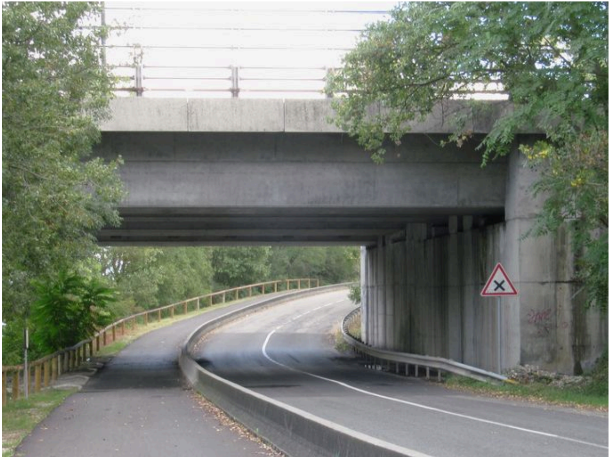
Extrémité rive gauche, face aval ; culée
