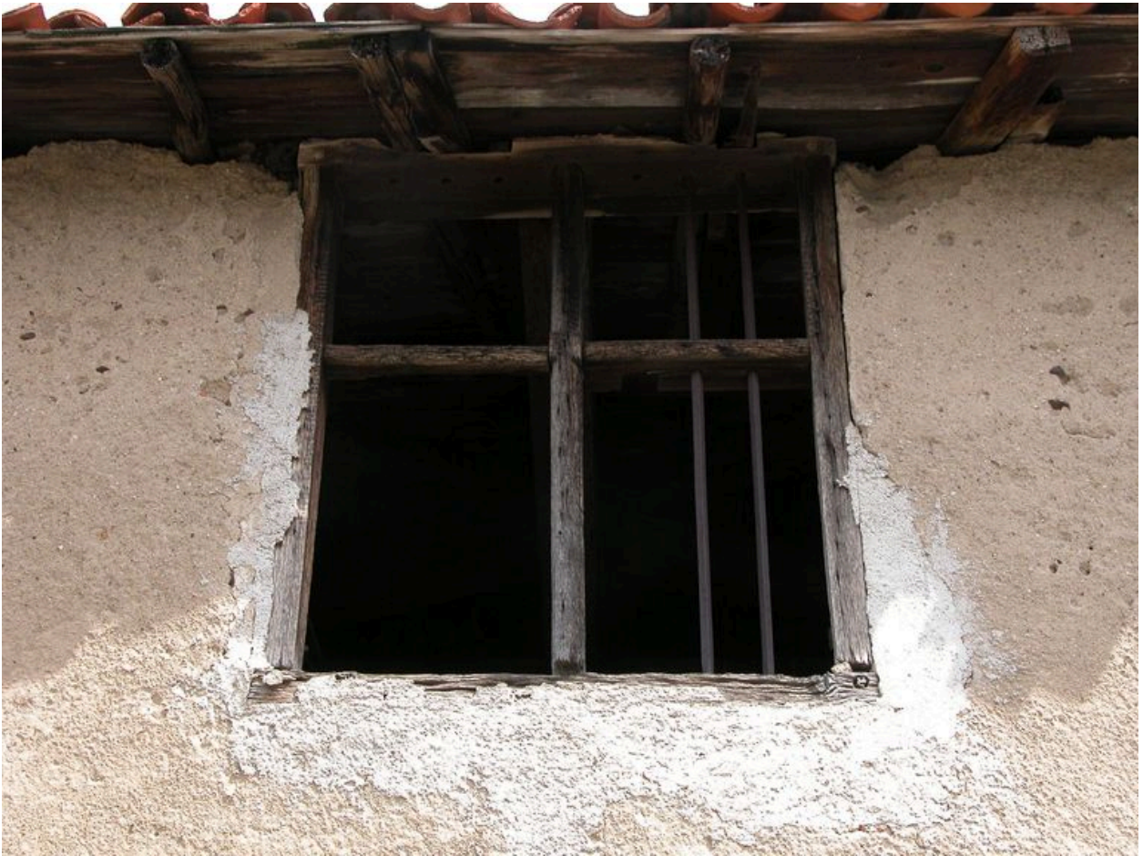
Détail de la fenêtre à croisée du bâtiment sud-ouest.
