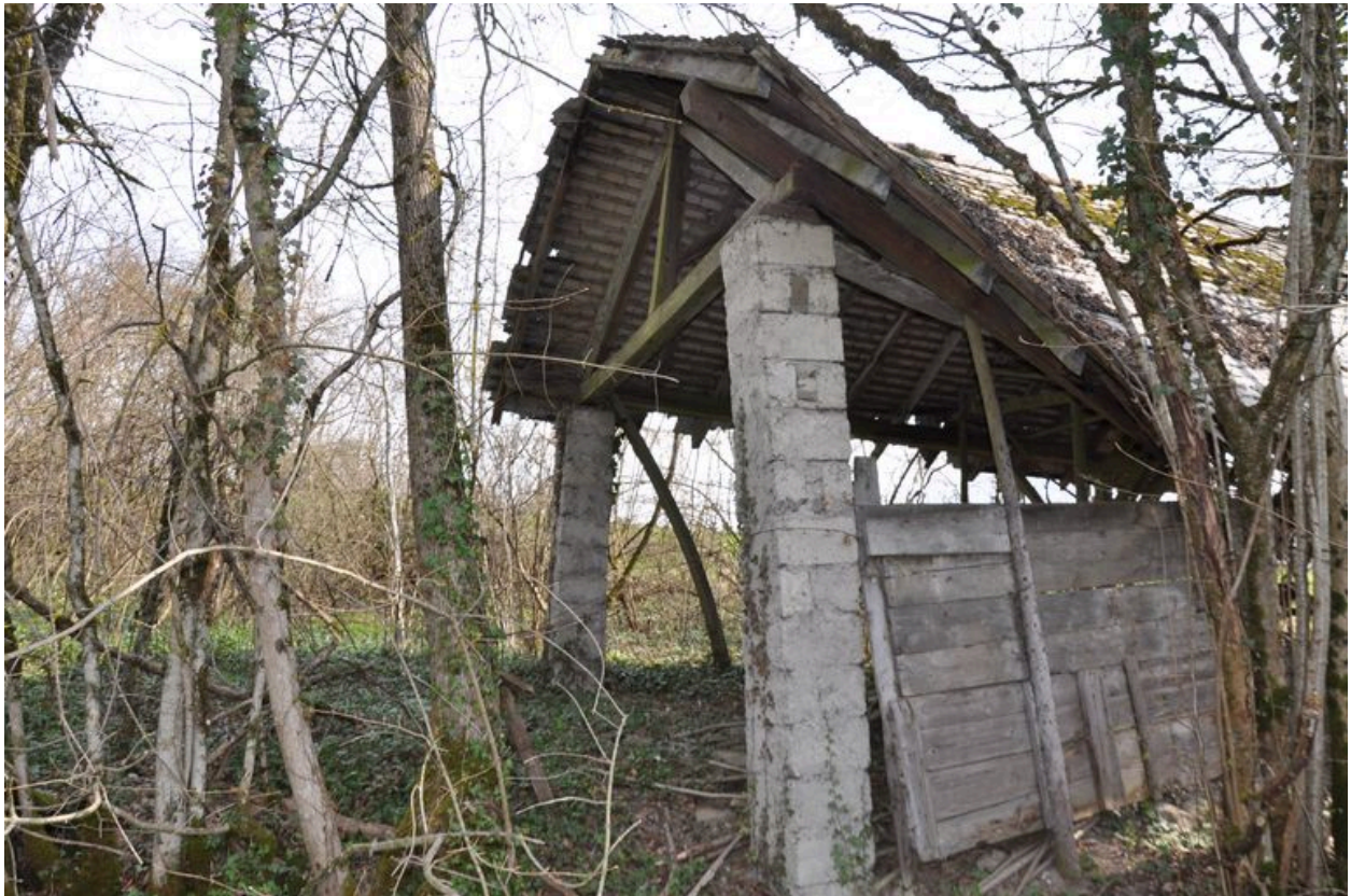
Piliers supportant la structure en bois du battoir
