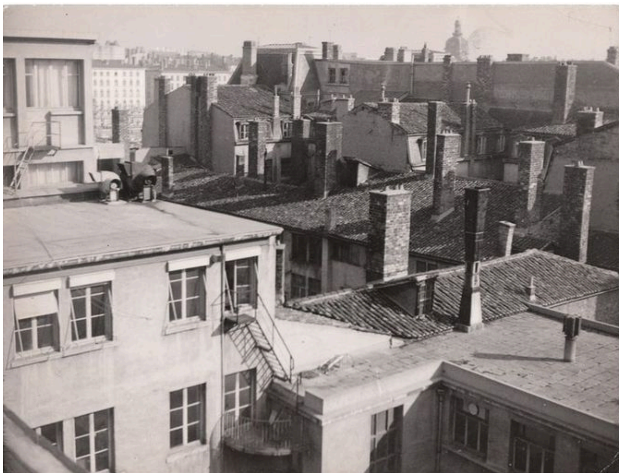
Vue des toitures avant travaux de démolition, photographie ancienne, 1970-1971
