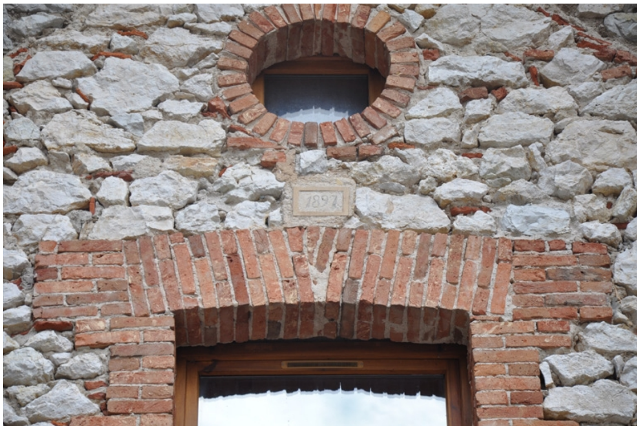
Détail de la façade ouest avec une date portée 1897
