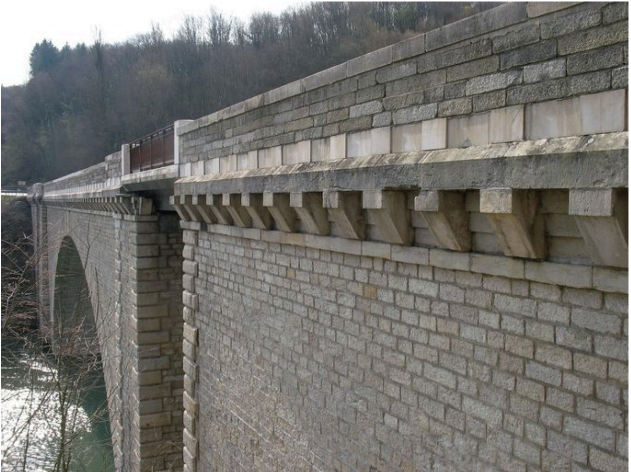
Vue de la face amont, depuis le haut de la rive droite
